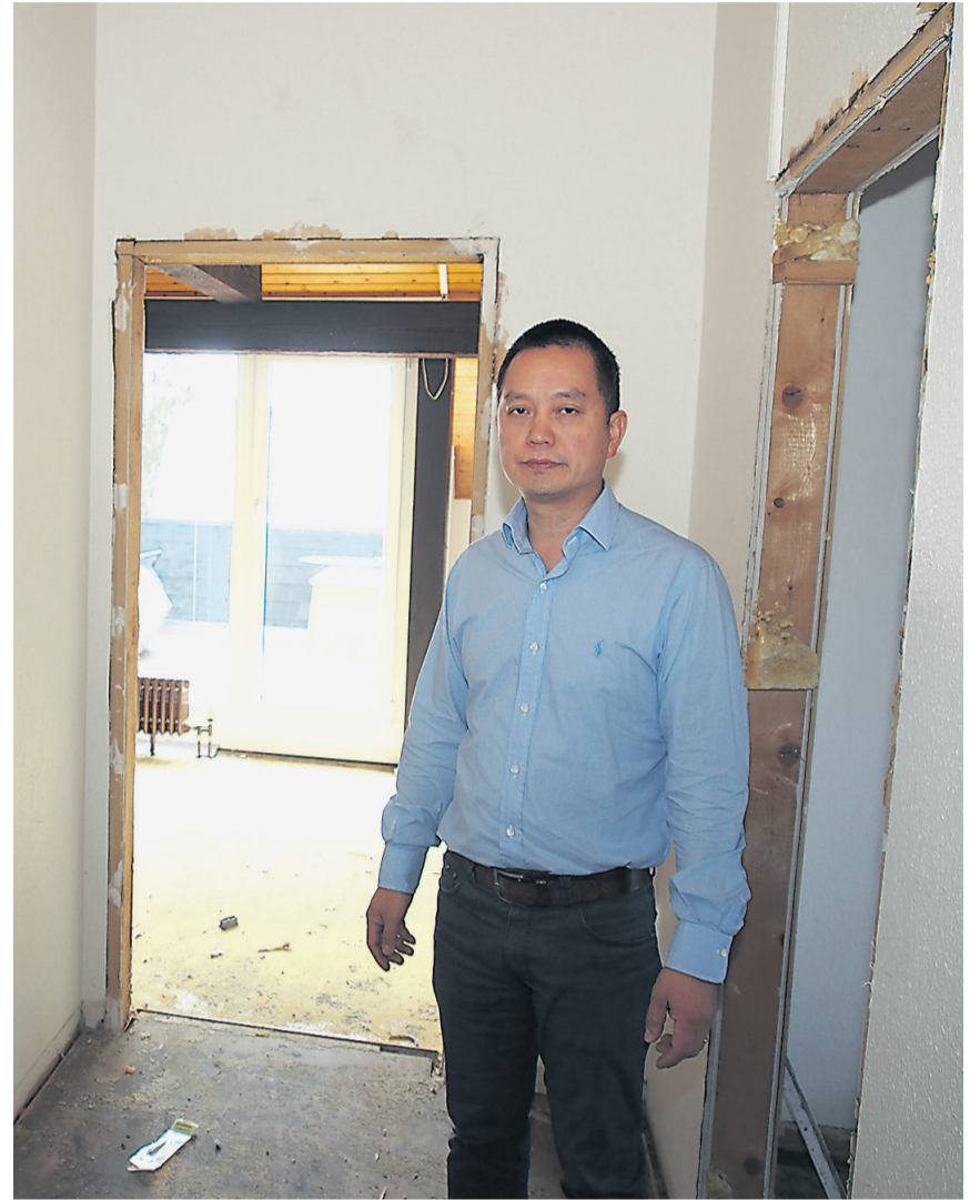
Yan Suping auf den Baustellen in den Zimmern des Altbaus des Hotel Danner: Seit Jahrzehnten war eine Sanierung überfällig.
