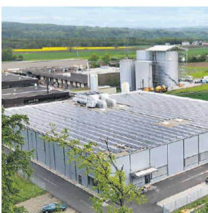
Die 3070 m 2 grosse Anlage auf dem Dach wird jährlich 500 000 kWh Strom produzieren.
