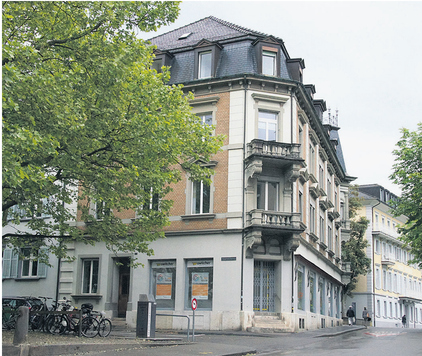
Im Kollerhaus an der Bahnhofstrasse in Rheinfelden soll eine Klinik-Abteilung untergebracht werden. Dazu ist ein Umbau notwendig.
