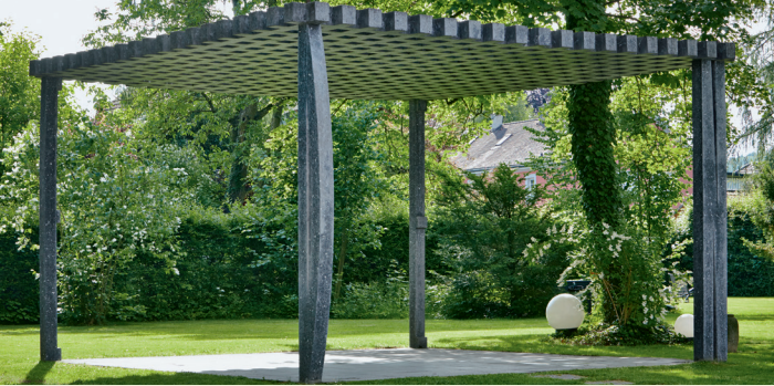
Pavillon Herzog & De Meuron, Hotel EDEN im Park
